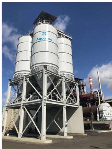
Figura 10: silos stoccaggio granulato sinterizzato (KEU)
